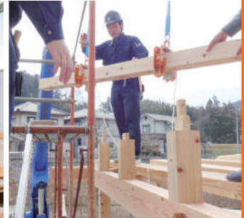
模擬家屋棟上げ実習
