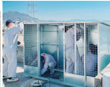
ゴミステーション設置
