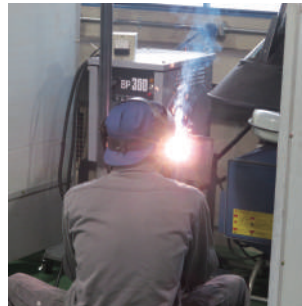
被覆アーク溶接作業
