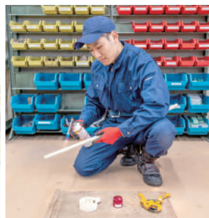
合成樹脂管工事
