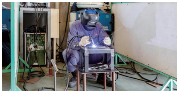
特殊溶接実習
