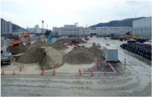
二次仮置場 (坂町) 処理中
