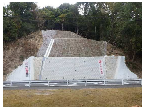
(主) 東海田広島線（安芸郡府中町）
