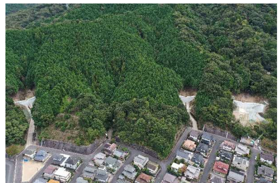
災害関連緊急治山事業 (広島市安佐北区)
