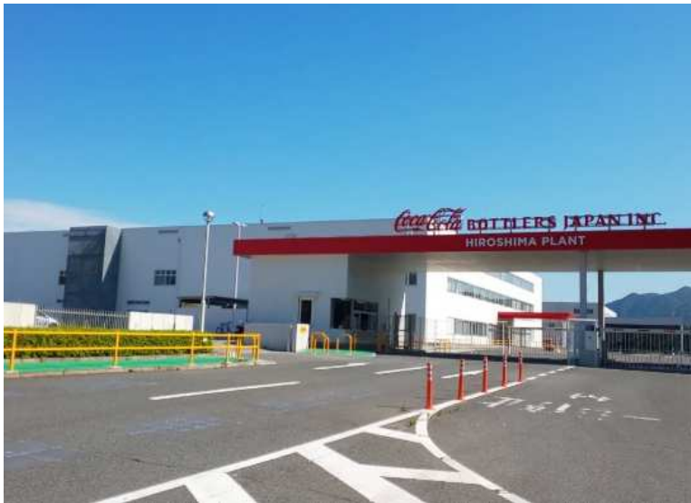
復旧後のコカ・コーラ ボトラーズジャパン(株) 広島工場 (三原市)
