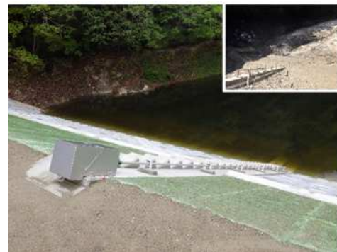
ため池の復旧工事状況 (尾道市)
