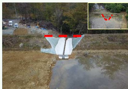
ため池の廃止工事状況 (安芸高田市)
