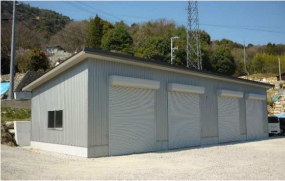
農業用倉庫の復旧状況 (呉市)
