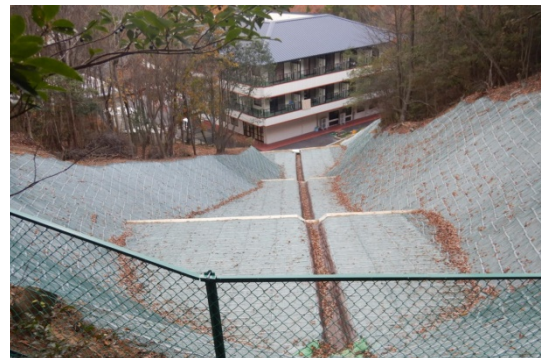
災害関連緊急治山事業 (東広島市)
