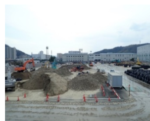
二次仮置場（坂町）処理中
