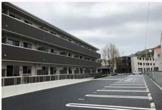
災害公営住宅（坂町）
